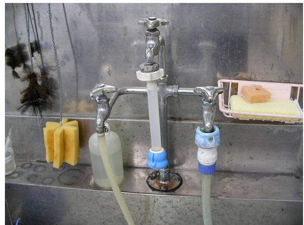
② ホース、蛇口金具等も取り外します
