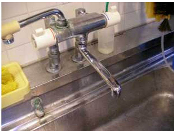
水栓だけの状況に戻します
