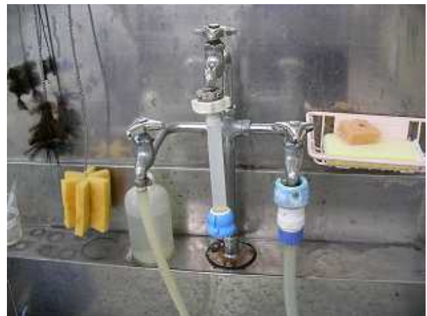
ホース、蛇口金具等も取り外します
